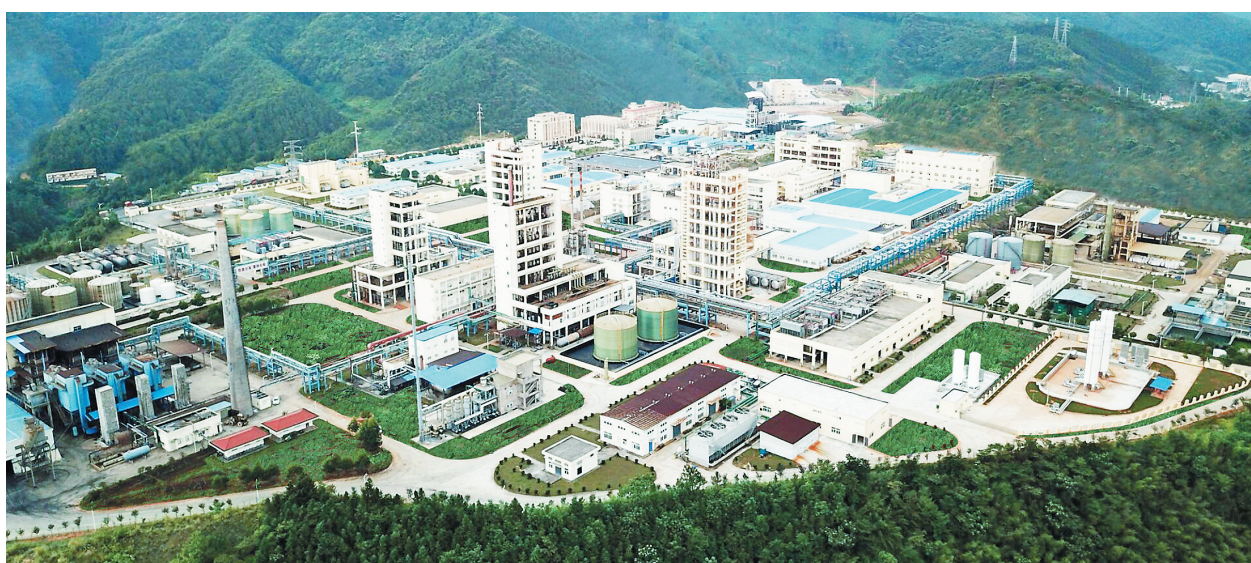
三元区黄砂新材料循环经济产业园
