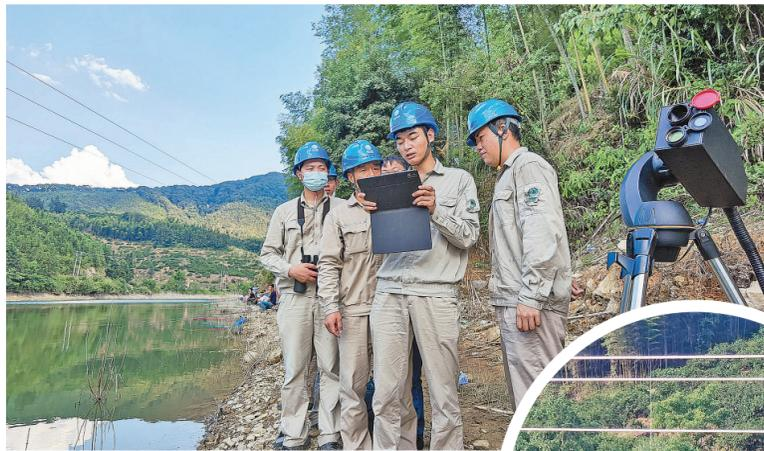
供电员工使用激光远程清除装置带电清除高压线上的鱼线。
