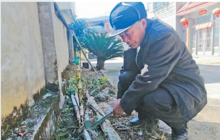
黄观水在维修近日被霜冻坏的自来水管和供水接头
