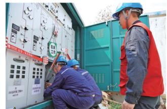
供电施工人员进行高压电缆T接
