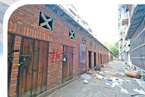
牡丹新村26幢柴火房拆除前。
