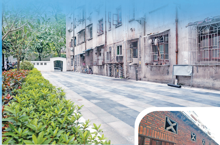
牡丹新村26幢柴火房拆除后,硬化了路面,增添了绿化带。
