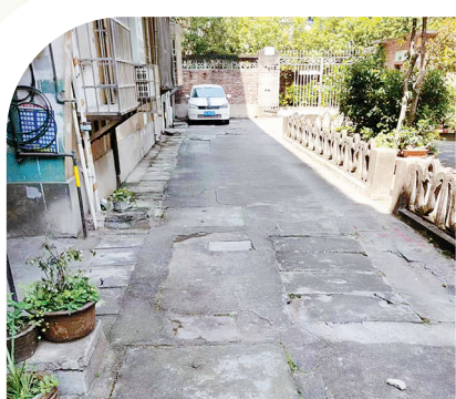
◀杜鹃新村8、9幢之间院子拆除前后对比
