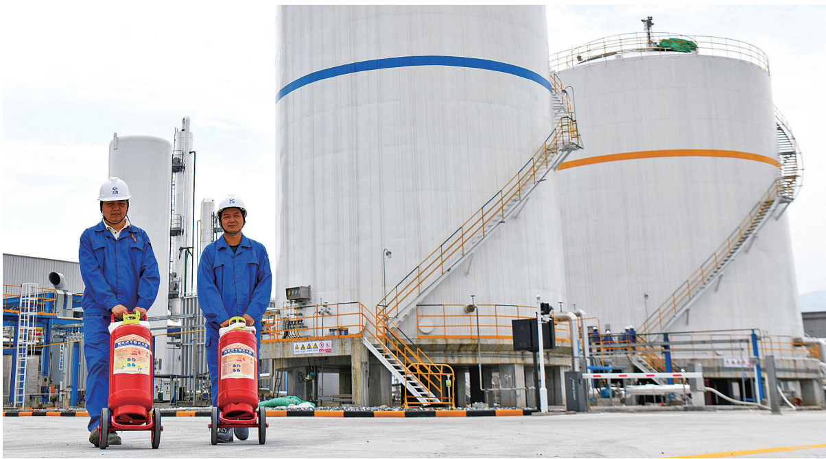
久策特种气体生产项目设备安装调试阶段
