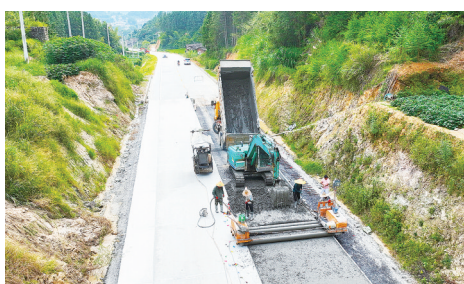
国道G235尤溪西城至新阳(大田界)公路工程一期施工现场,工人正在进行路面混凝土施工 (尤溪县融媒体中心供图)
