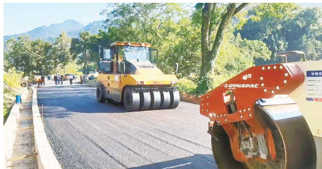
西汤线(X732)西滨至后楼段公路项目施工现场 (尤溪县融媒体中心供图)
