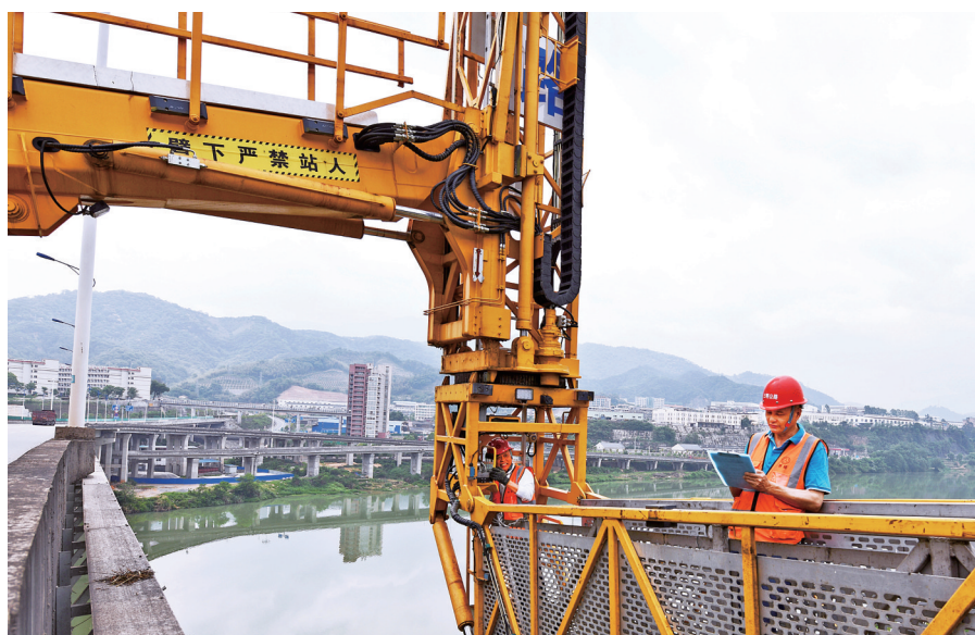
罗文水在检测桥梁状况
