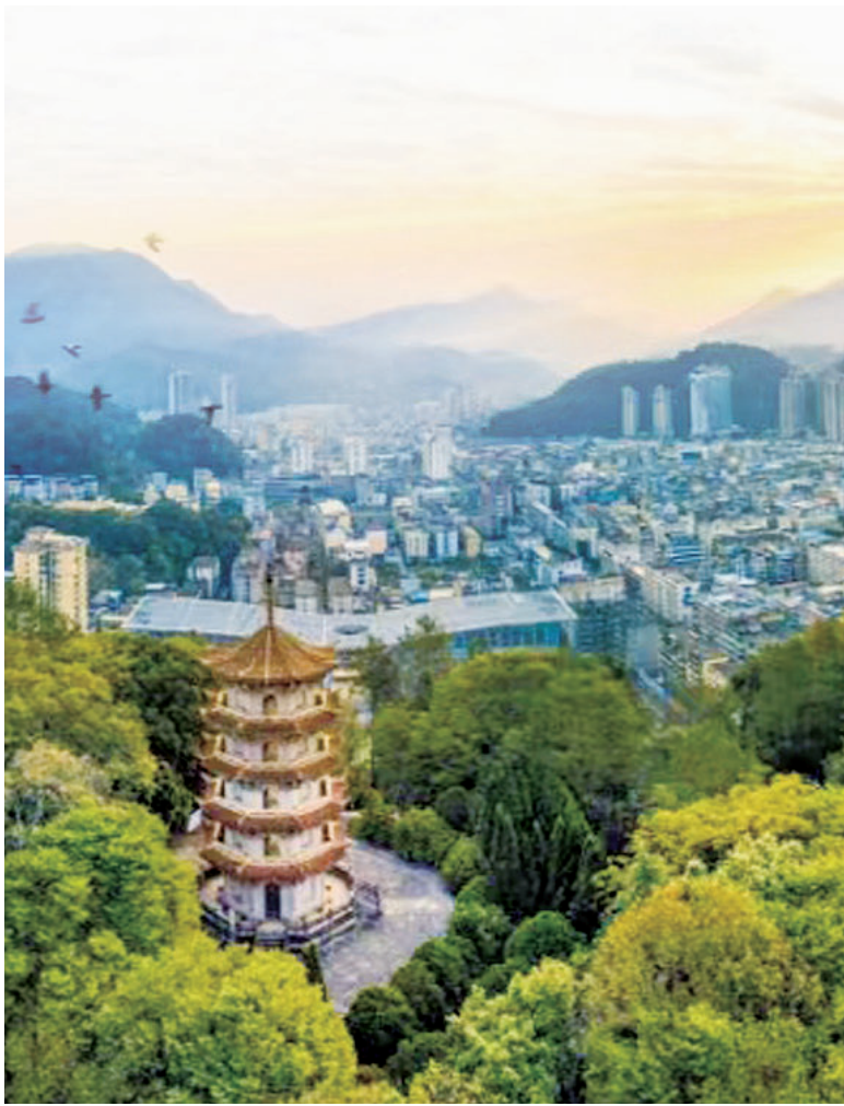
承载着岩城记忆的新大田（苏晋银 摄）
