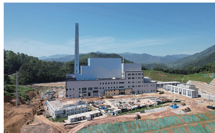
省重点项目永安市垃圾无害化项目建设现场 (陈胜泉摄)
