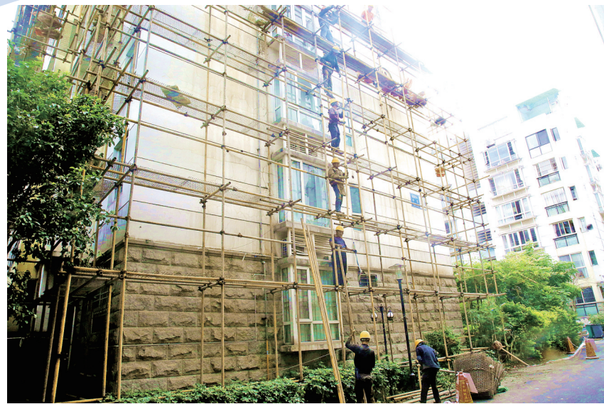
景泰秀水小区改造现场
