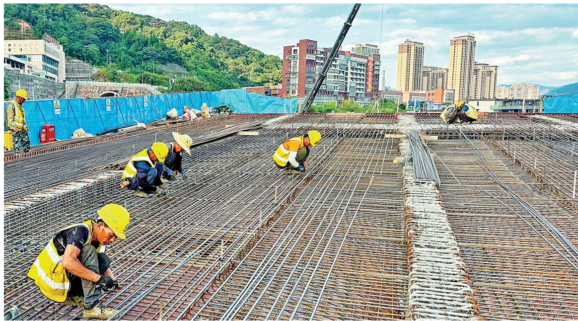
三明南站片区枢纽工程提速增效
