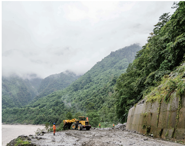
在墨脱县格当乡,工作人员在抢通道路(2023年10月12日摄)。
