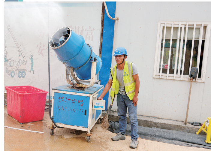
雾炮机喷出强力水雾,有效控制扬尘。
