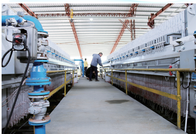
金东矿业尾矿建材化压滤车间
